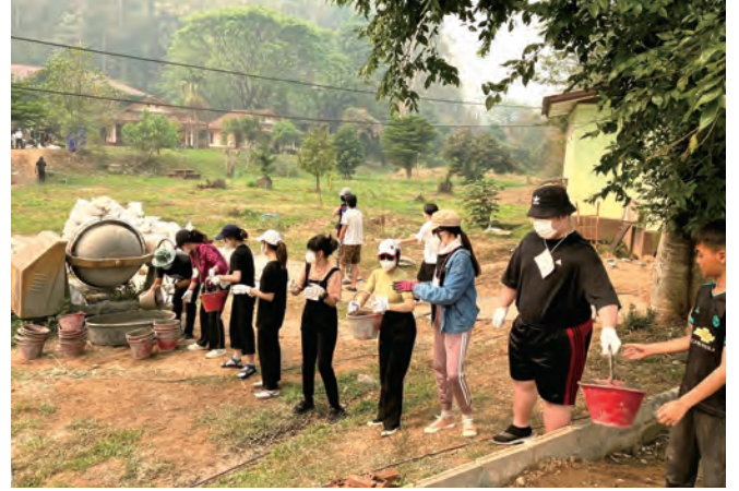
セメントのバケツリレー
