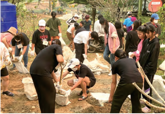
土砂積めと搬送作業
